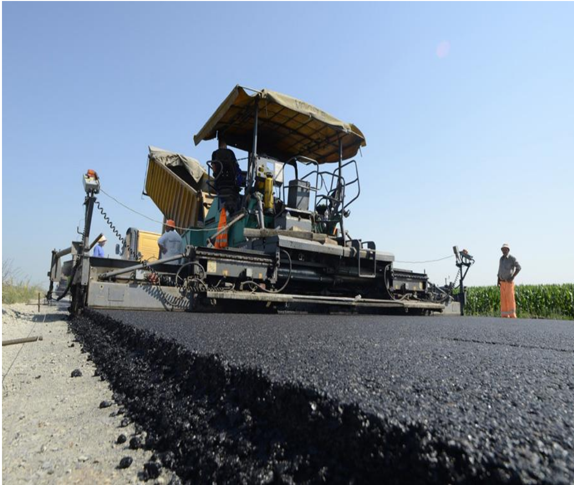
Слика 3. Инвестиционо одржување на патиштата – (надградба и поправка (рехабилитација) на дотраени коловози)
