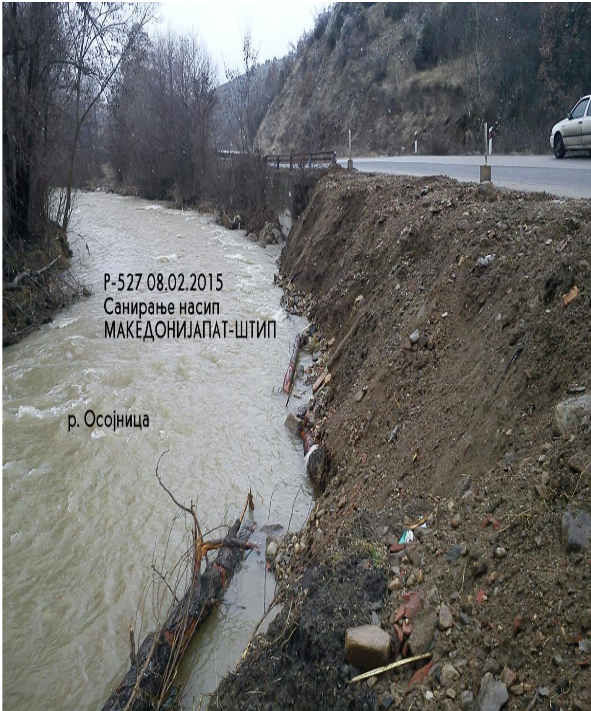
Слика 23. Поткопување на трупот на патот
