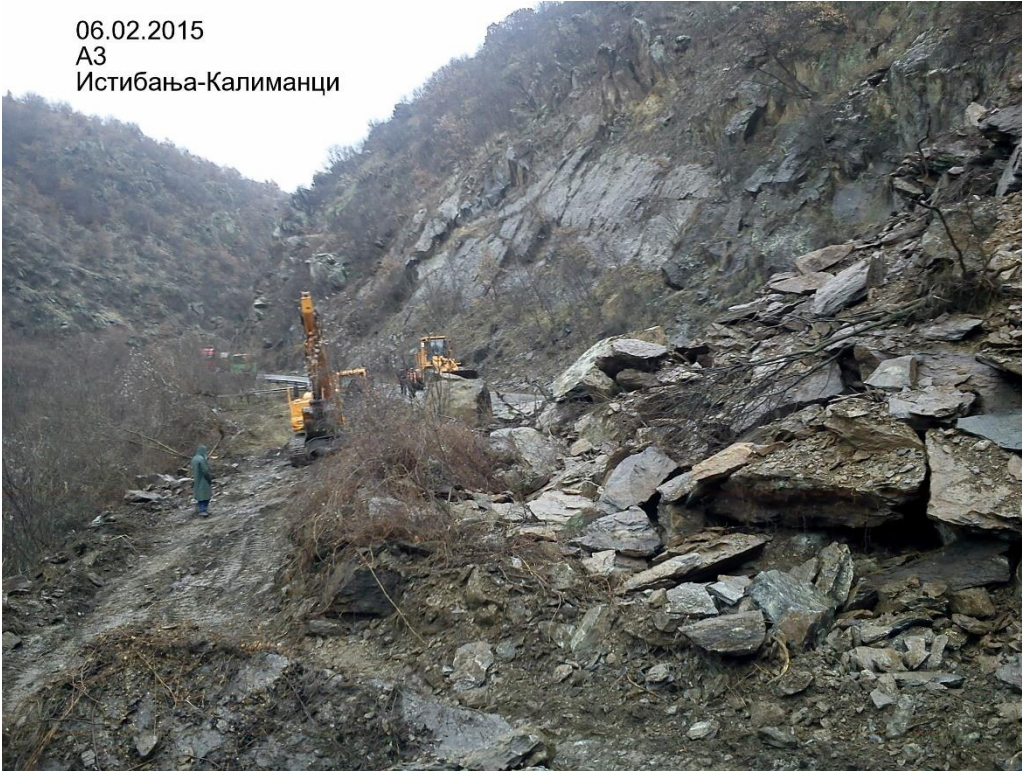
Слика 6. Изработка на девијација по појавата на свлекување на пат А3 Истибања – Калиманци 2015 г.
