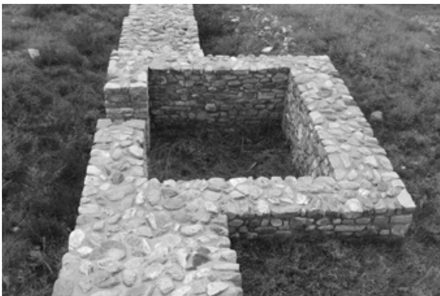
Сл.2 Правоаголна кула 2 од северозападниот одбранбен ѕид
