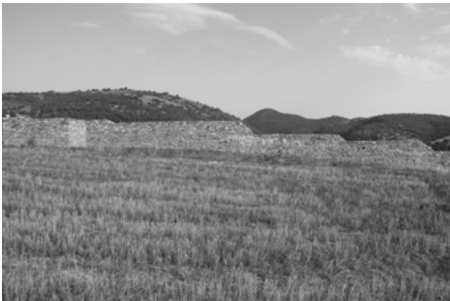
Сл.1 Северозападен одбранбен ѕид
