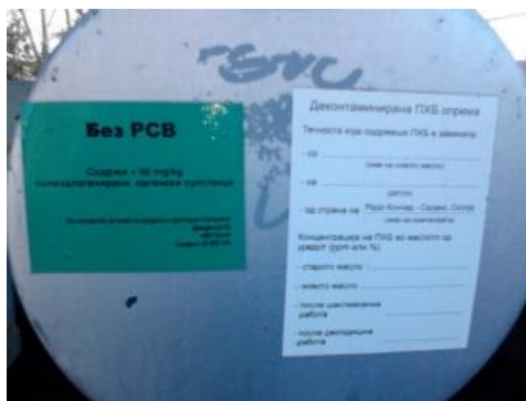
Слика 12 : Налепница за деконтаминирана PCB опрема Figure 12: Sticker for decontaminated PCB equipment
