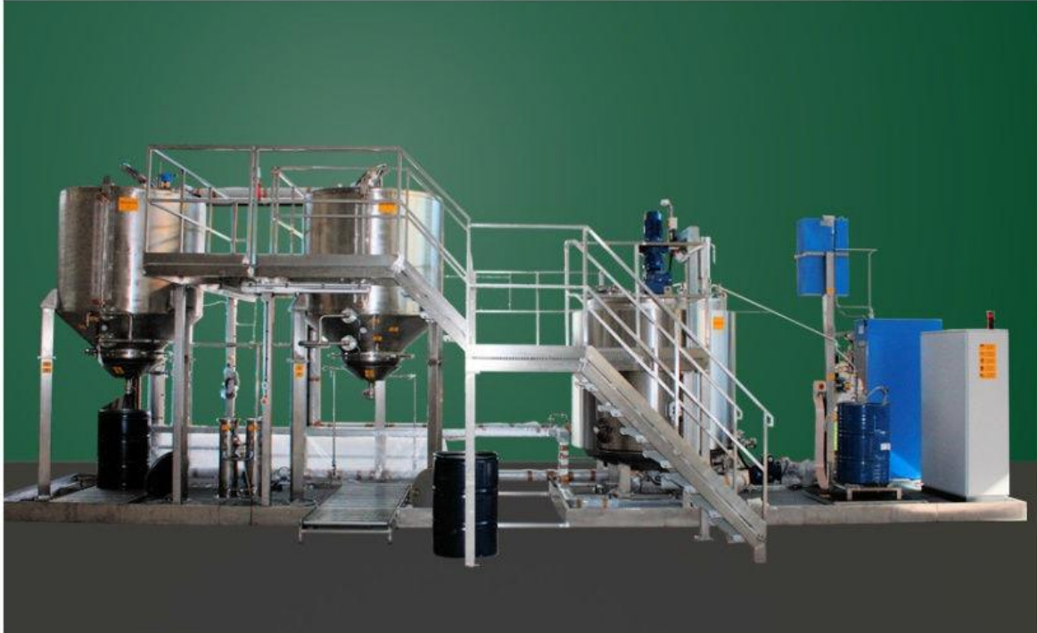
Сл. 25: Постројка за дехалогенизација и детоксификација Figure 25: Installation for decontamination and dehalogenation
