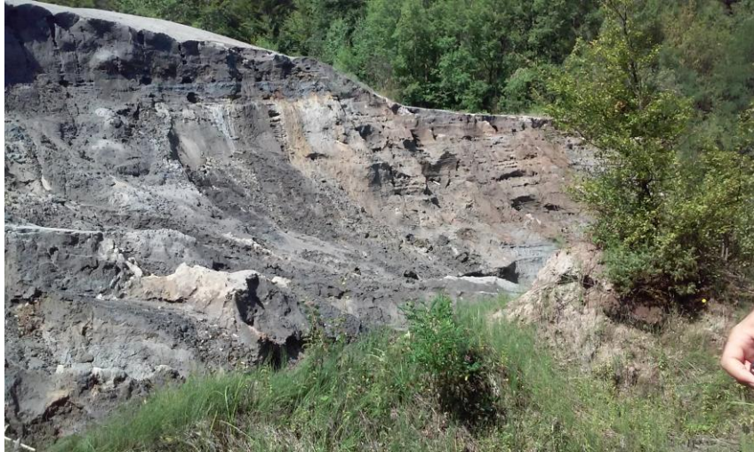
Слика 9. Флотациско јаловиште на рудникот “Stolice” оштетено во поплавата – продор на материјалот од јаловиштето
