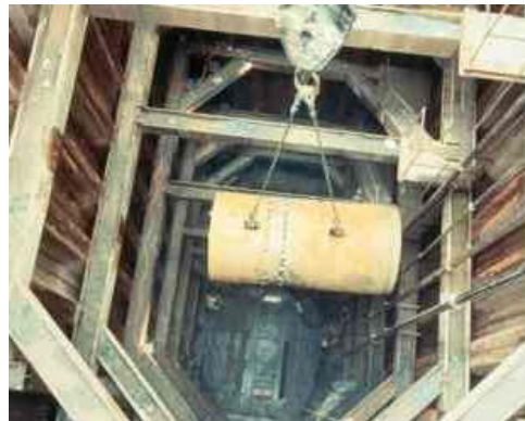
Слика 4. Спуштање на цевка во шахтата
