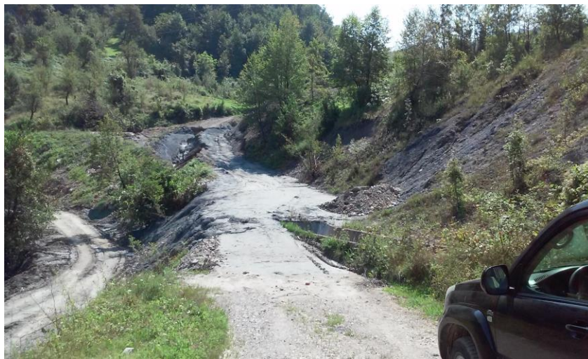
Слика 8. Флотациско јаловиште на рудникот “Stolice” оштетено во поплавата – излевање на јаловината на локалниот пат
