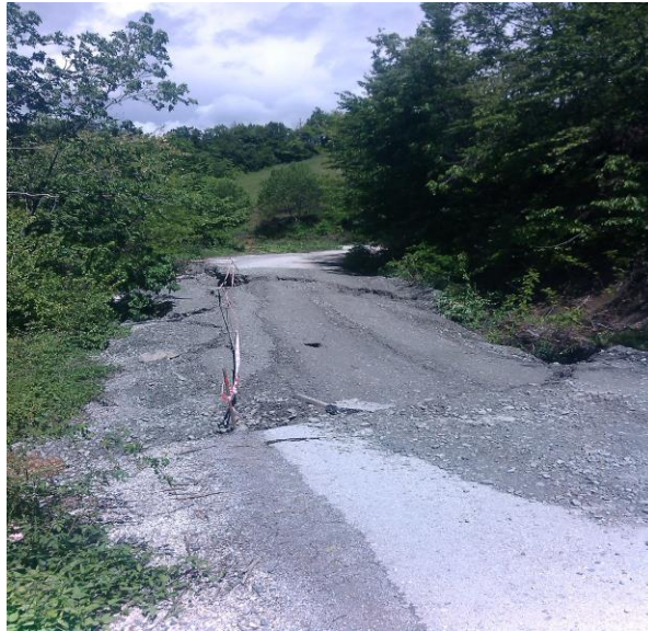
Слика 5. Оштетен пат од јамата до флотацијата во рудник “Рудник”
