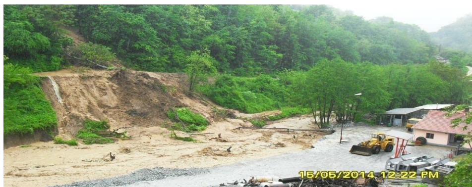
Слика 3. Оштетување на средишниот дел од рудничкиот круг во рудникот "Veliki Majdan" со уништен дел од локалниот пат
