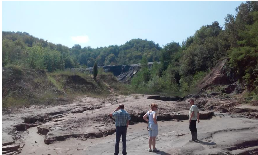
Слика 7. Флотациско јаловиште на рудникот “Stolice” после поплавите – пробој на јаловина и материјали од јаловиштето
