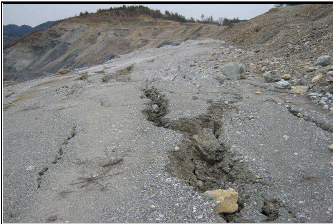
Слика 26. Појава на секундарни тензиони пукнатини во рамките на депонијата Figure 26. Occurrence of secondary tension cracks with in the waste disposal
