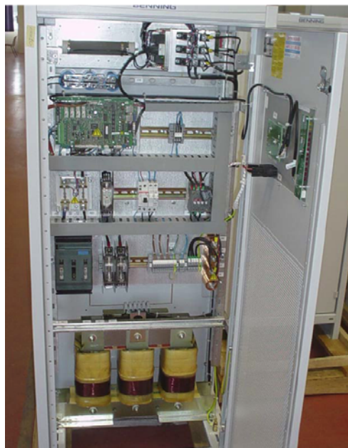
Слика 8. Исправувач тип ТИ СБ 380-220/40 А ТД2
