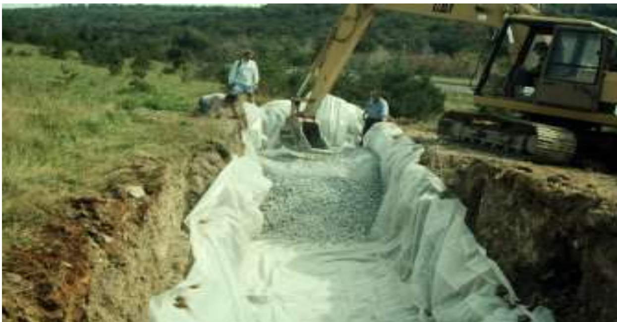
Слика 13. Безкислородни варовнички дренажи (ALD) Figure 13. Anoxic Limestone Drains (ALD)
