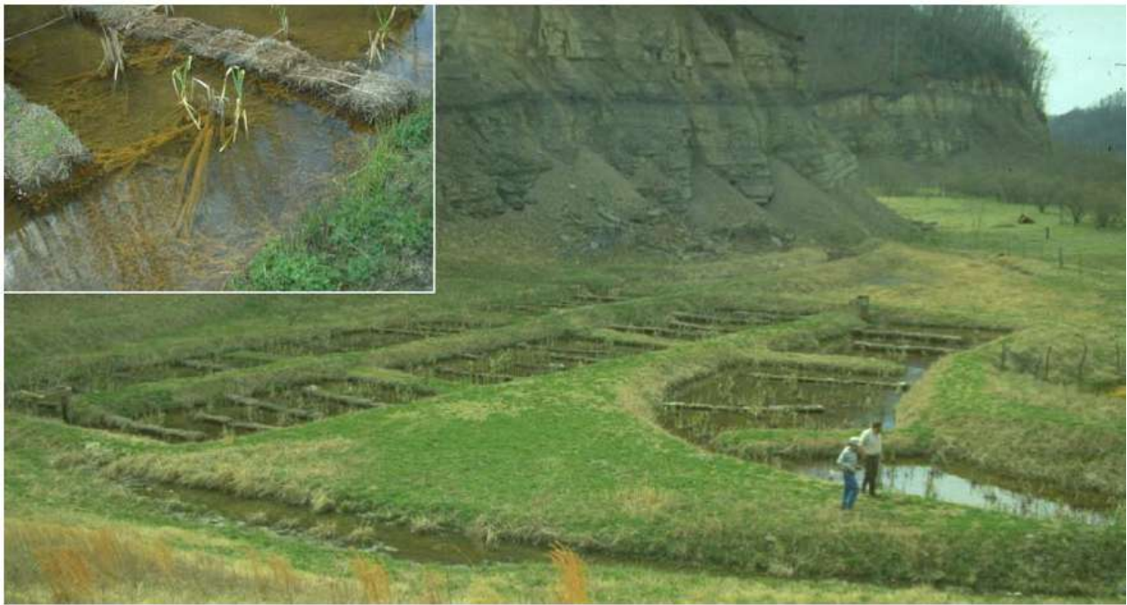
Слика 11. Физички бариери поставени за спречување на канализирањето на протокот
