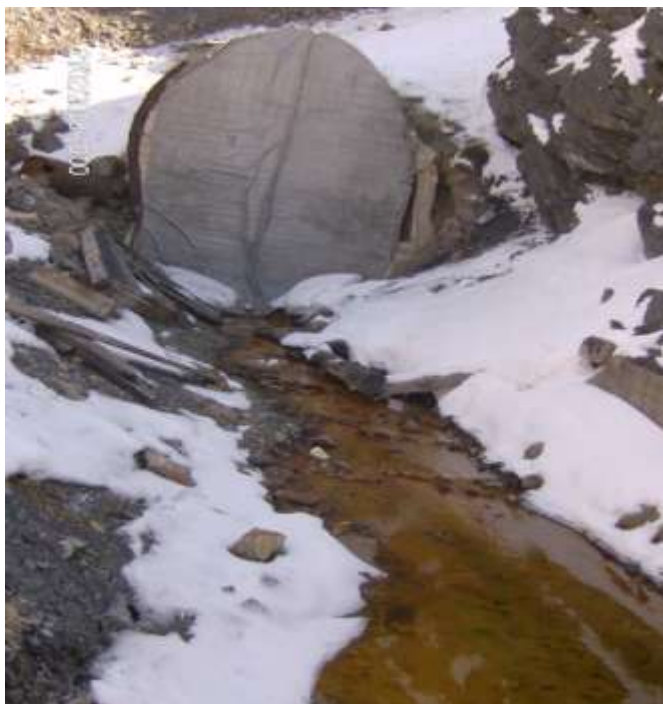
Слика 35. Појава на т.н. “yellow boy” во јамските води од стара неактивна јама “II” Figure 35. Outbreak of so- called “yellow boy” in the mine water from abandoned pit “II”
