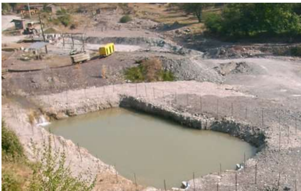
Слика 87. Таложник на хор.830 Figure 87. Settling pond on a hor.830
