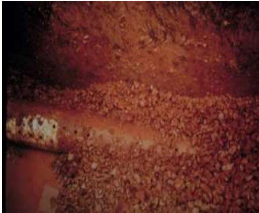
Слика 15. Блокирање на ALD Figure 15. Clogging of ALD
