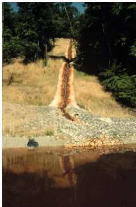
Слика 20. Отворен варовнички канал сместен на стрмнина со пад поголем од 20% Figure 20. OLC placed on slopes of greater than 20%
