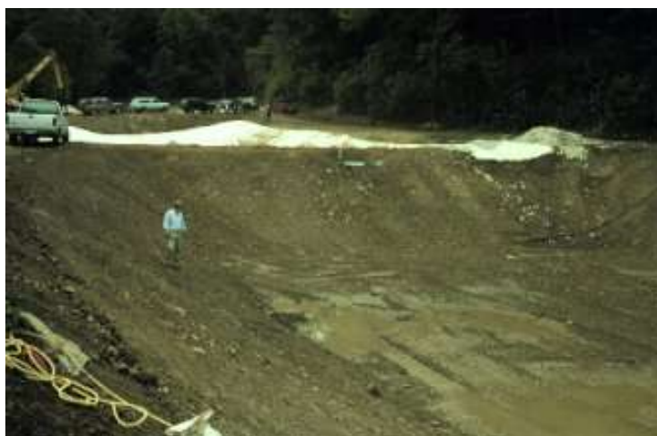
Слика 28. Варовнички таложник конструиран на местото на излегување на подземните води
